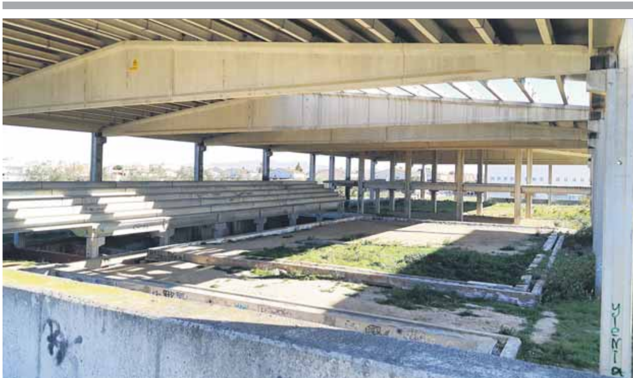
L'estat actual de l'edifici que es rehabilitarà per transformar-lo en l'espai Àgora ■ AJ. VILAFANT
